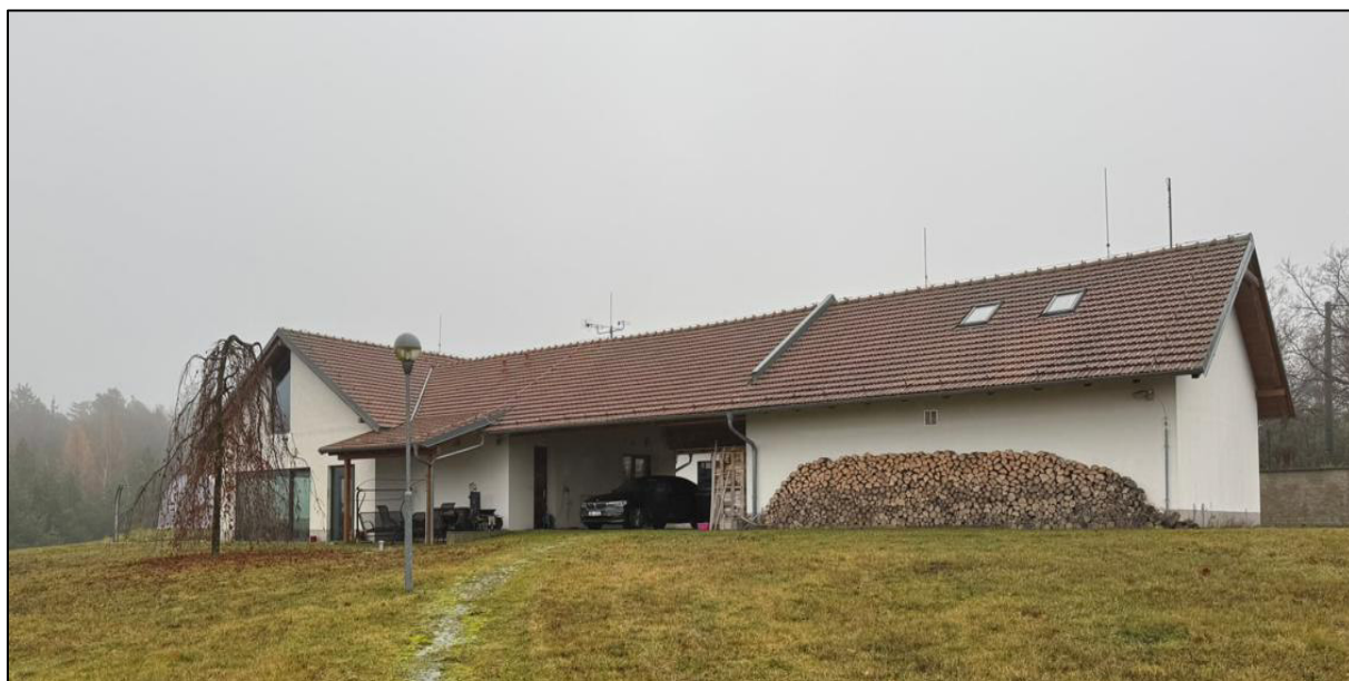
Obrázek č. 13 – Rodinný dům č.p. 545, LV č. 1160, k.ú. Lelekovice
